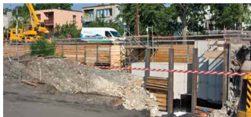
Ve stanici Kladno-Ostrovec už jsou viditelné zárodky nového podchodu.
