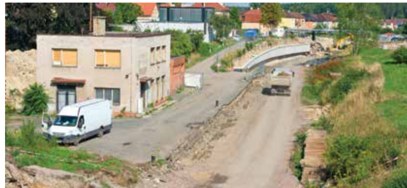
V budově na zastávce Kladno město budou umístěny nové technologie.
