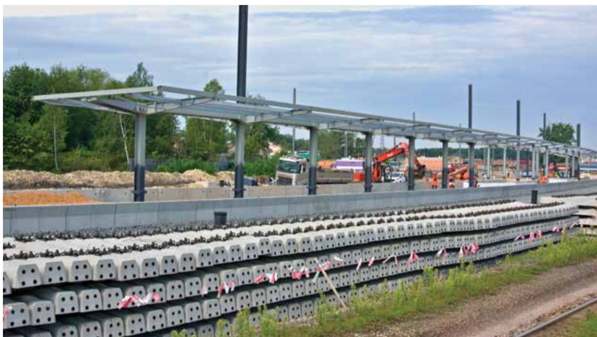
Ve stanici Kladno se staví první z budoucích nových nástupišť.
