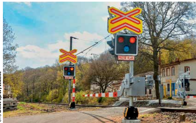
FOTO: archiv Správy železnic
