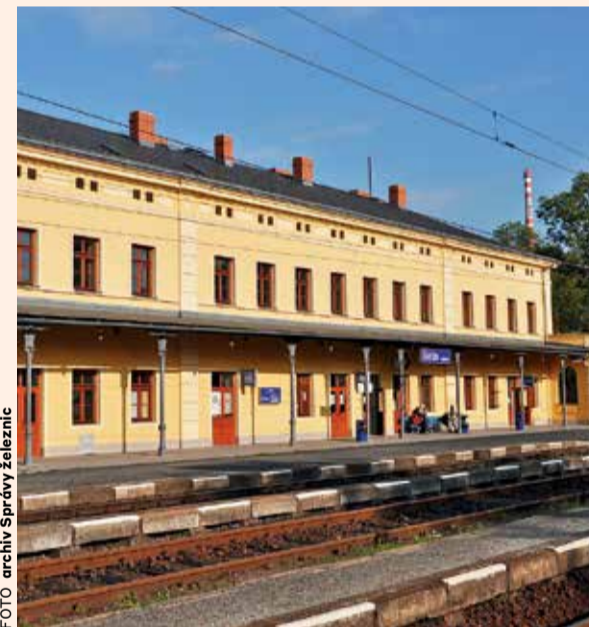
FOTO archiv Správy železnic
