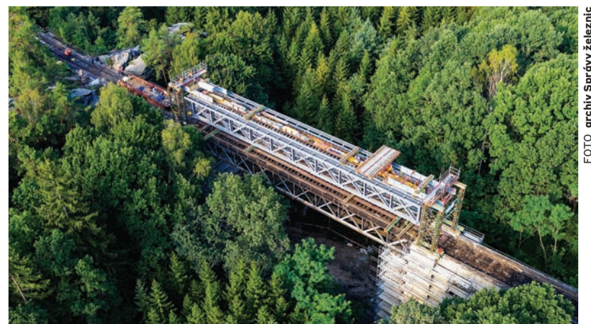
FOTO archiv Správy železnic
