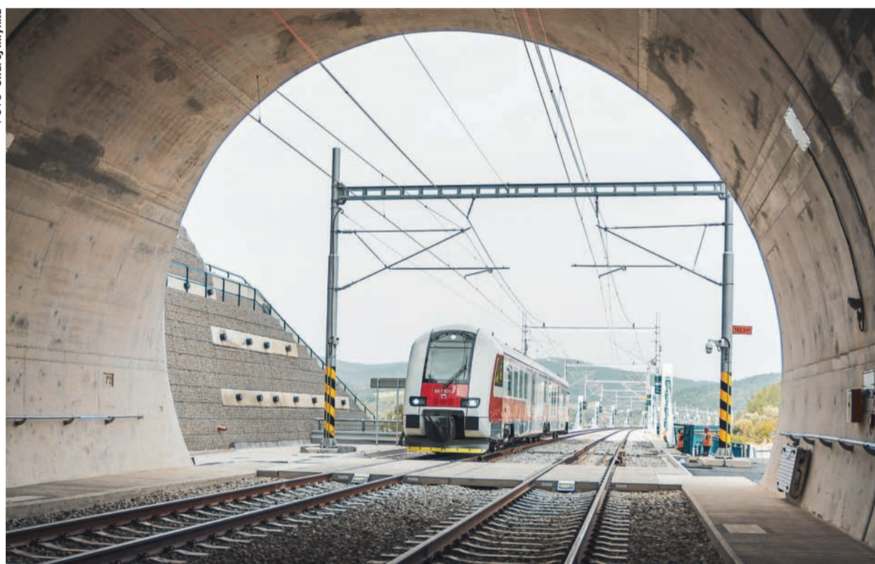
Záběr ze zvláštní jízdy po nové přeložce s tunelem Diel, konané 16. září
