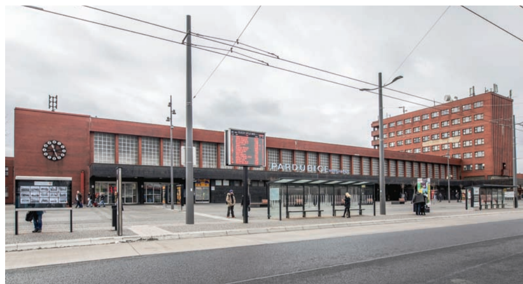
FOTO archiv Správy železnic
