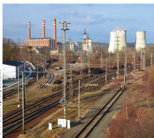
FOTO archiv Správy železnic
