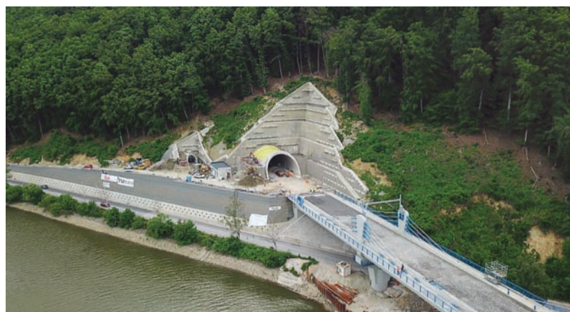
Výstavba tunelu Diel...
