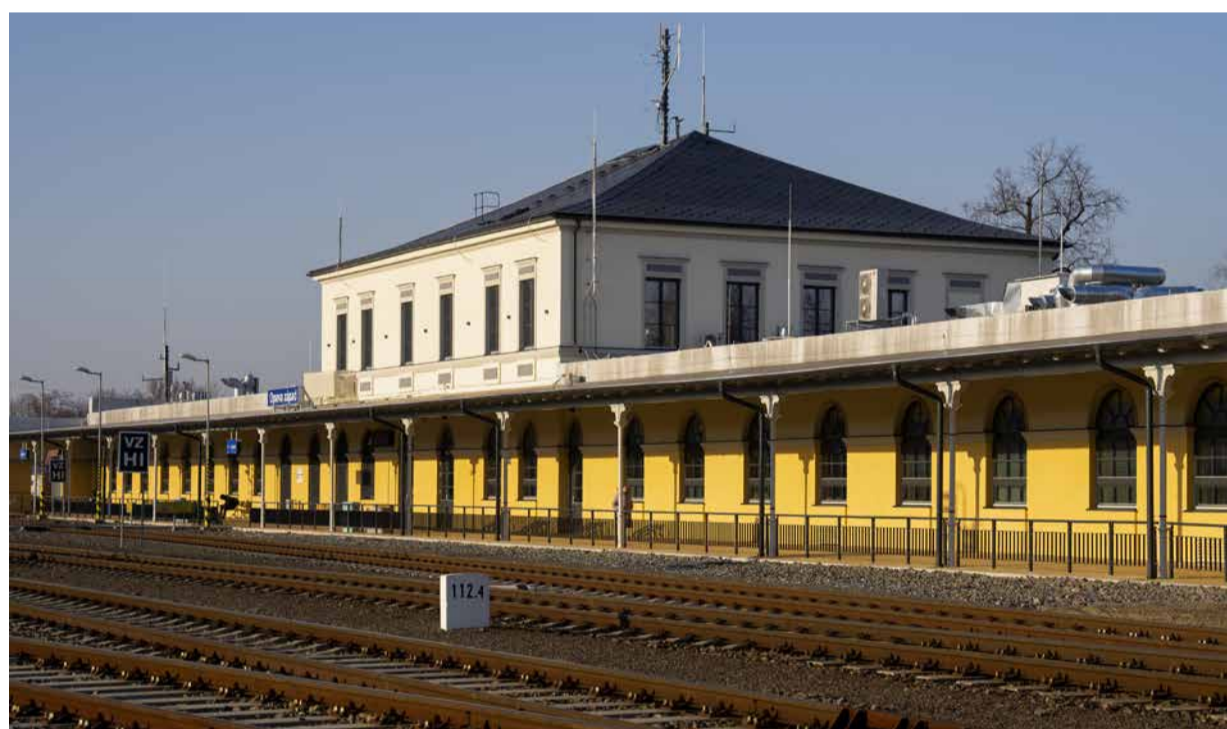
FOTO archiv Správy železnic (2x)
