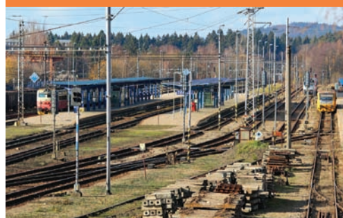
FOTO archiv Správy železnic
