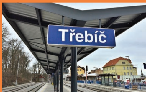
FOTO archiv Správy železnic
