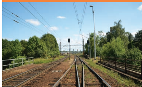
FOTO archiv Správy železnic
