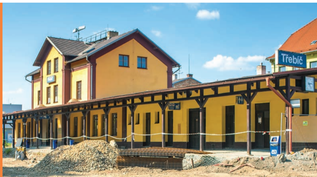
FOTO archiv Správy železnic
