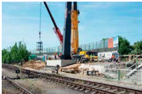
Výstavba budoucí lávky přes silnici a železnici
