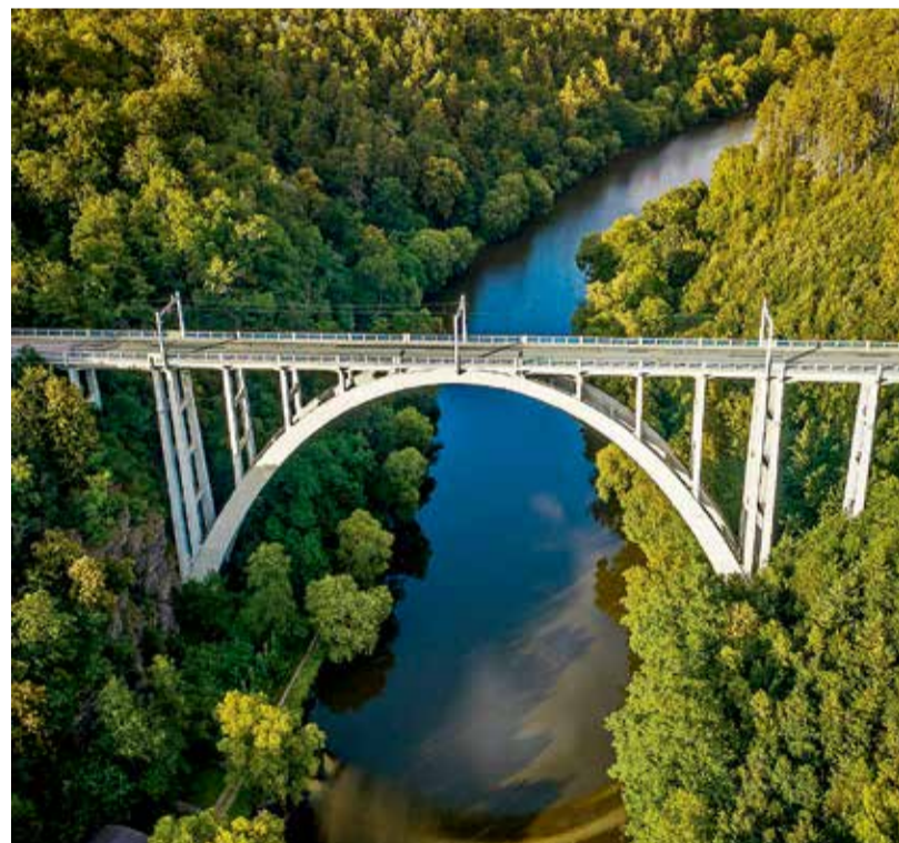
FOTO archiv Správy železnic
