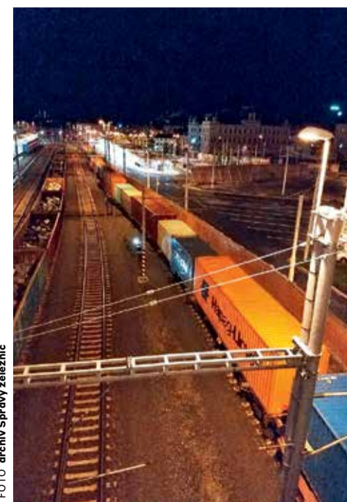
FOTO: archiv Správy železnic
