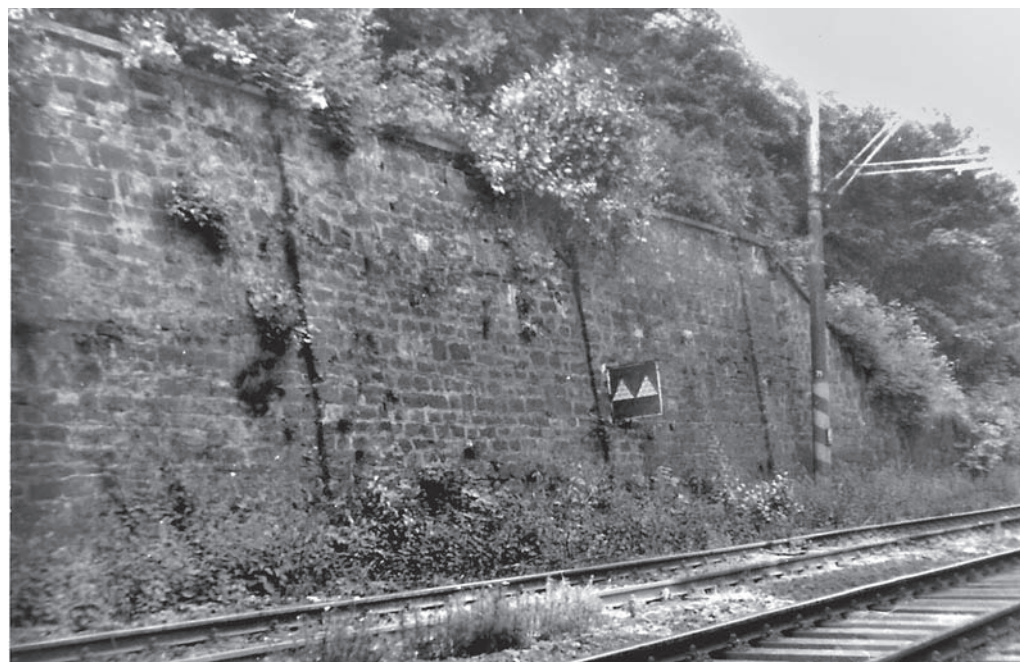
„Mlhovka“ v původním čtvercovém provedení před vjezdovým návěstidlem tehdejší stanice Praha střed. Léto 1985
