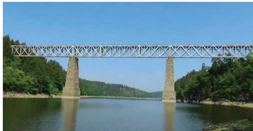
Současná podoba mostu přes Orlickou přehradu
