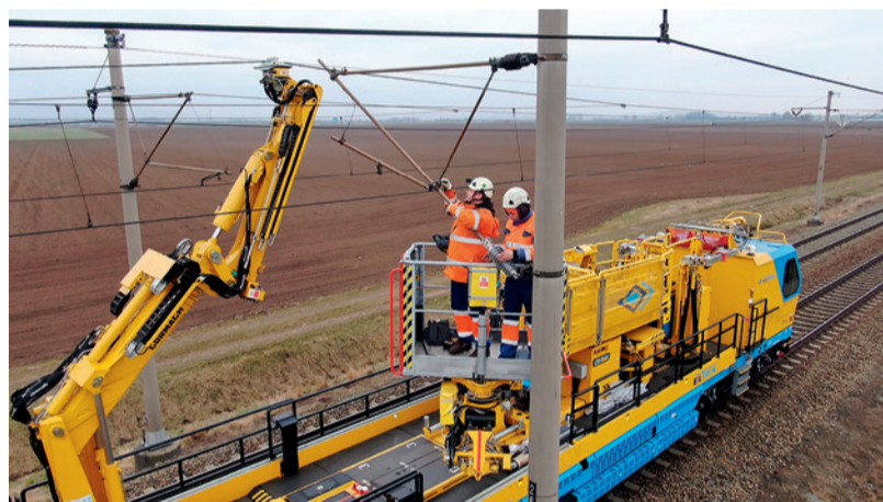
FOTO archiv Správy železnic (3x)
