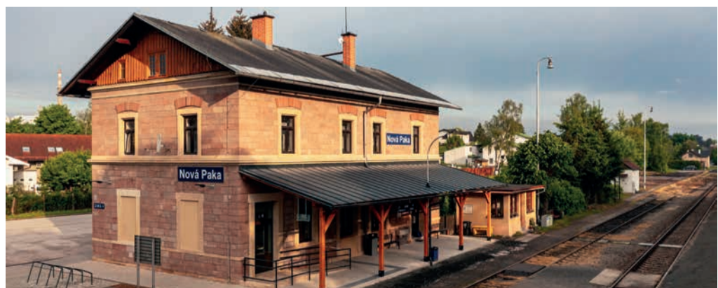
FOTO archiv Správy železnic
