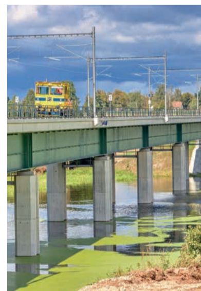
FOTO archiv Správy železnic
