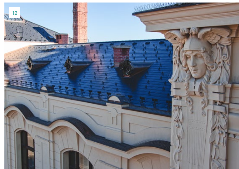
11 — Pohled z autobusového nádraží na z velké části opravenou fasádu a střechu nádražní budovy
