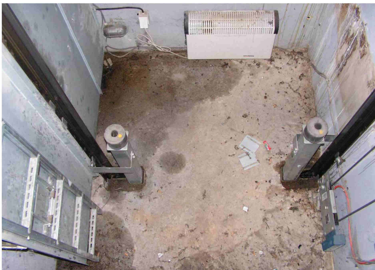
Břeclav, výtahová šachta
