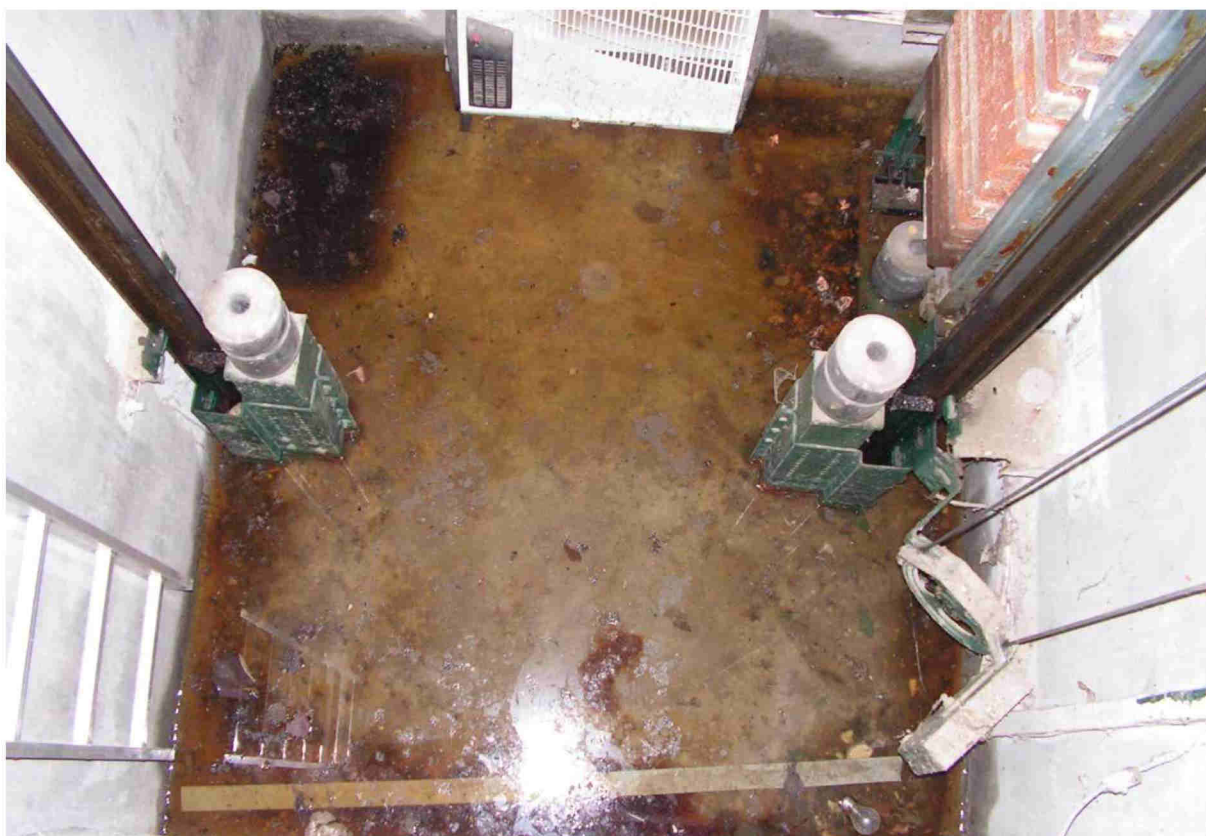
Šakvice, výtahová šachta
