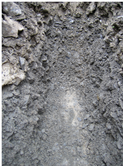
Stav konstrukční vrstvy
