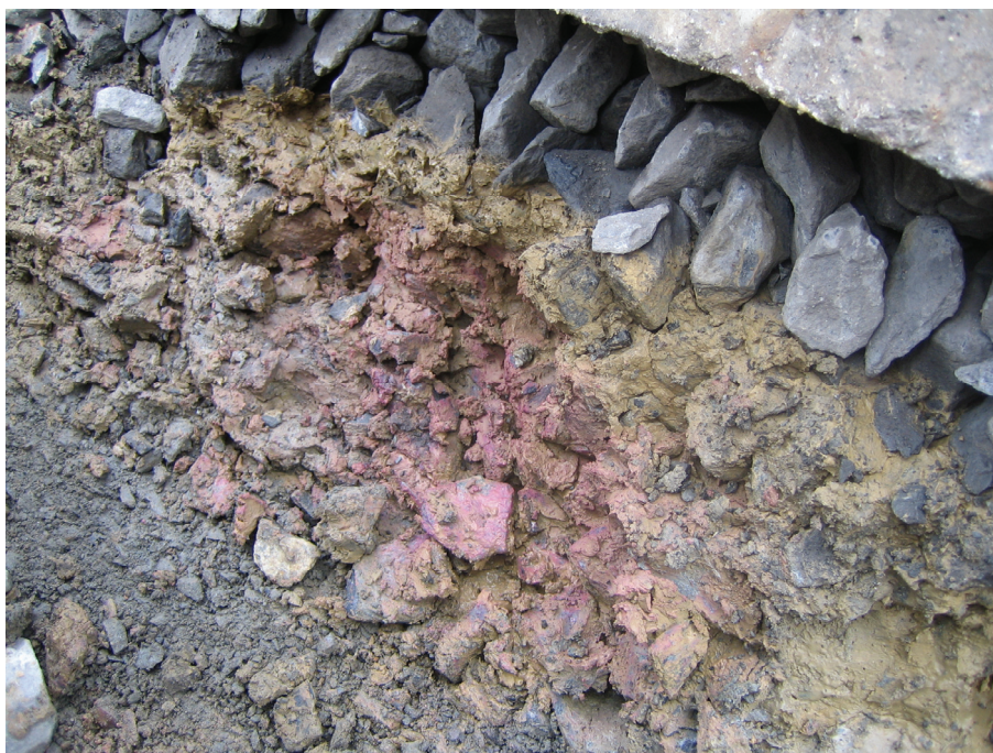
Stav kolejového lože
