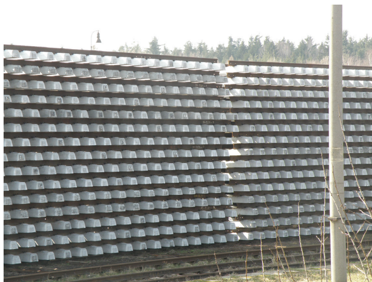
Obr. 2 Nesprávně skladovaná předmontovaná kolejové pole
