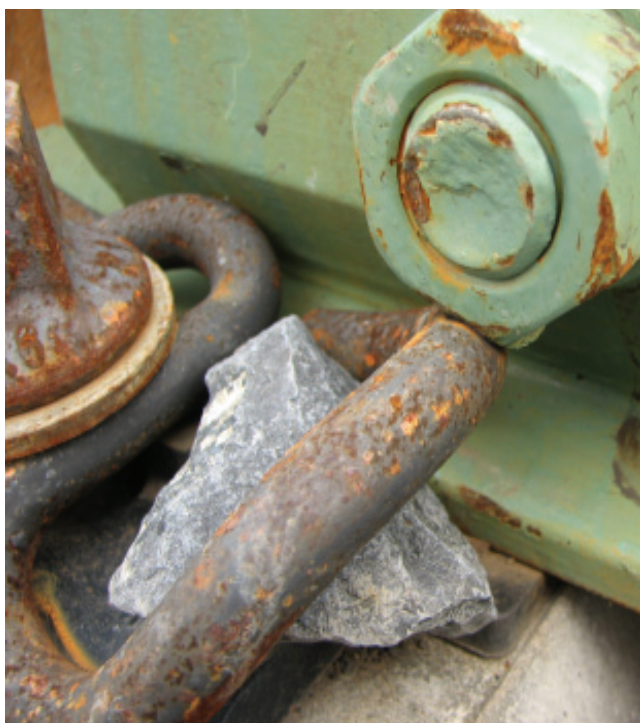
Obr. 5 Chybně použitá svěrka Skl 14 v LIS soustavě S 49
