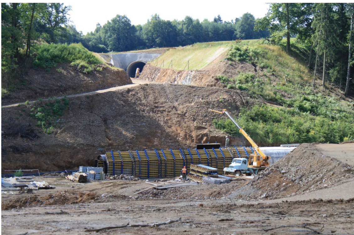
Obr. 7 Výjezdový portál tunelu Tomický II a navazující žel. spodek
