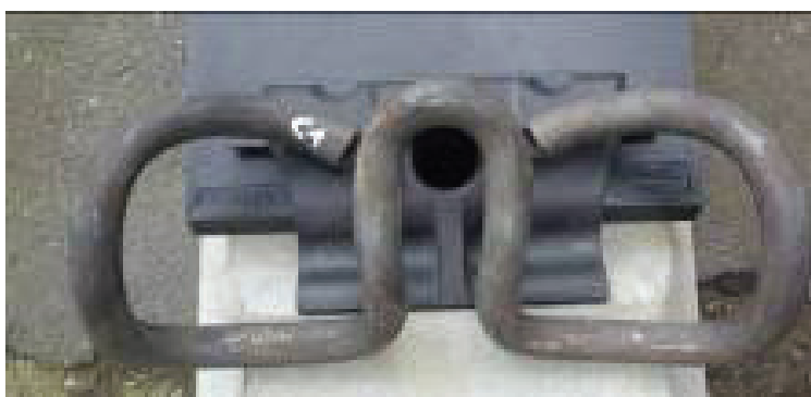
Obr. 5 Systém upevnění s masivní pružnou svěrkou, speciální rozšířenou úhlovou vodící vložkou a antiabrazivní podložkou na pražci
