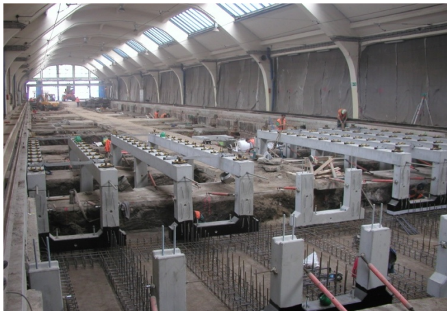
Obrázek 10: Montáž revizních kolejí vozovny „shora-dolů“
