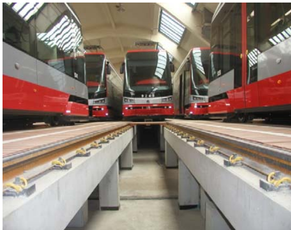
Obrázek 11: Pohled do prostoru revizní koleje vozovny
