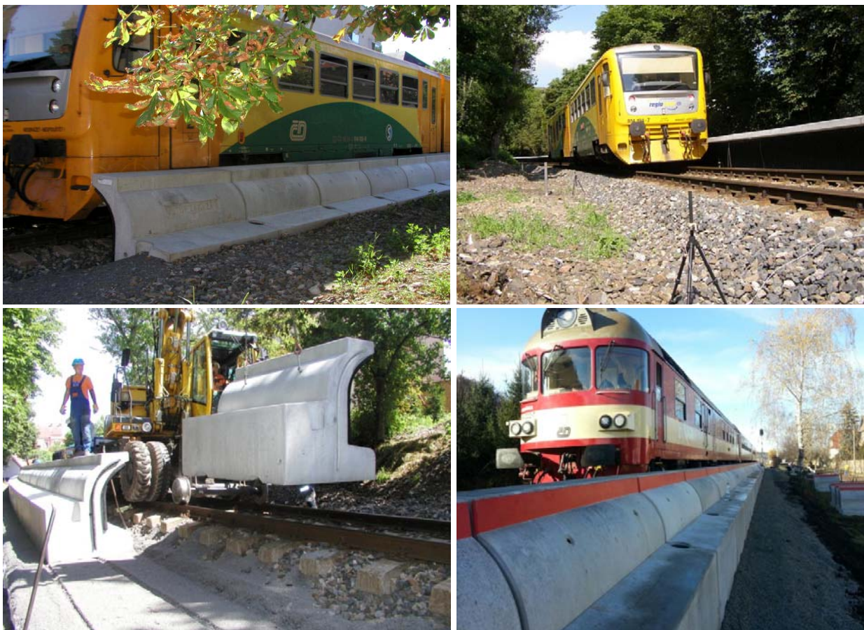
Obrázek 18: Pohled na zkušební aplikace nízké protihlukové clony – SŽDC - Praha Hlubočepy a Tetčice
