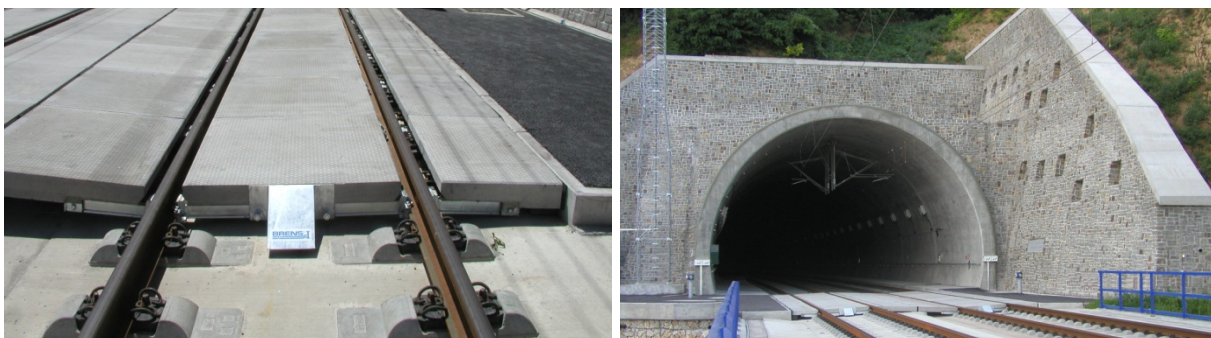
Obrázek 19: Záchranné a přístupové plochy BRENS ACCESS – ŽSR – tunel Turecký vrch
