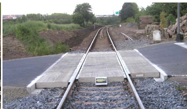
Obrázek 21: Přejezdová konstrukce BRENS, SŽDC - Zbuzany
