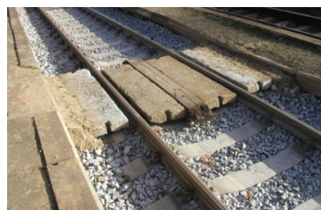
Obrázek 21: Přejezdová konstrukce BRENS, SŽDC - Zbuzany
