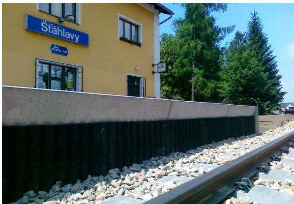
Obrázek 14: Protihlukové opatření nástupištní hrany H 130
