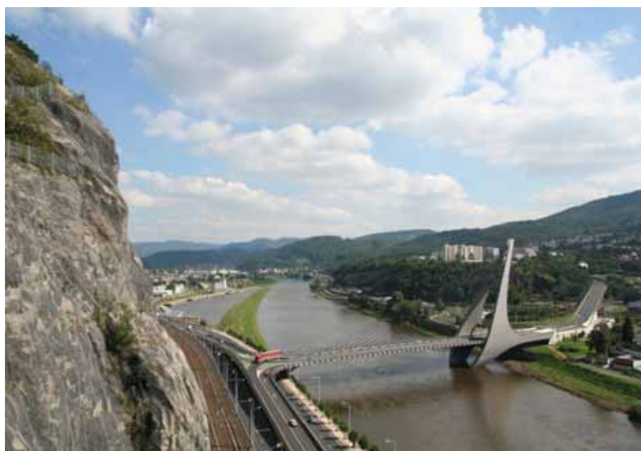
Obr. 4: Pohled z Mariánské skály na Mariánský most a Labe směrem k Děčínu, Mariánská skála je nejvyšší sanovaný objekt v republice
