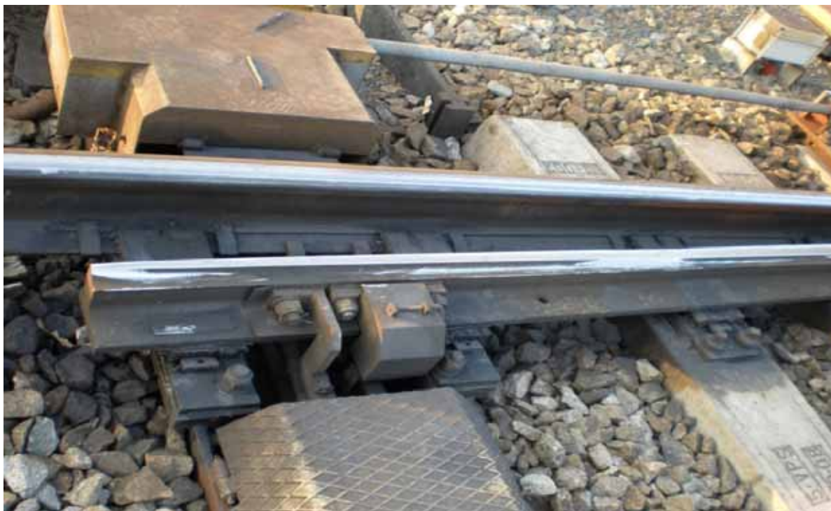
Obr. 6: Jazyk výhybky po broušení
