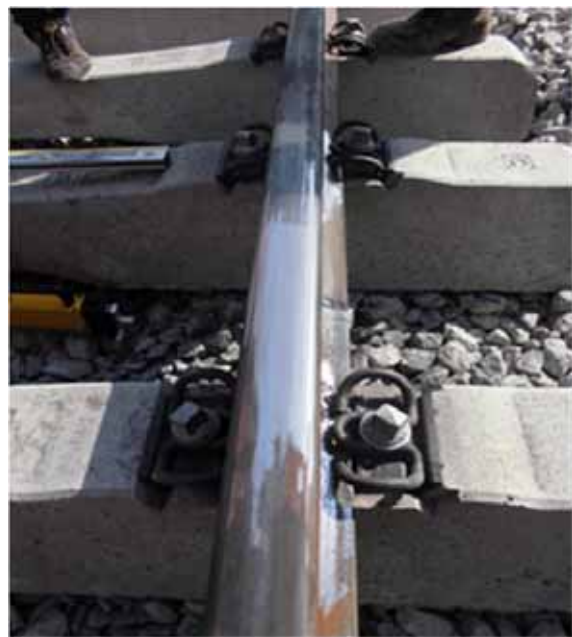
Obr. 7 - 9: Provedené svary před a po obroušení [2]
