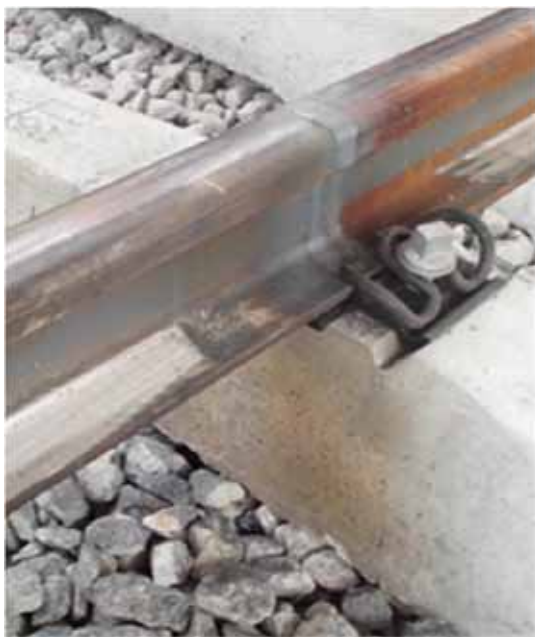
Obr. 7 - 9: Provedené svary před a po obroušení [2]
