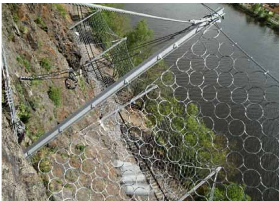
Obr. 3: Pohled na dokončování ochranných bariér 2000 kJ 05/2015 nad tratí u Skochovic
