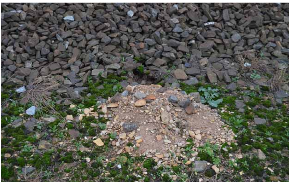
Obr. 6: Vyhrabaná štěrkopísková vrstva pod kolejovým ložem
