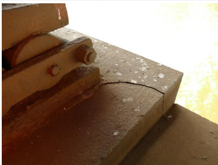
Pilíř P 02 úložný práh:
