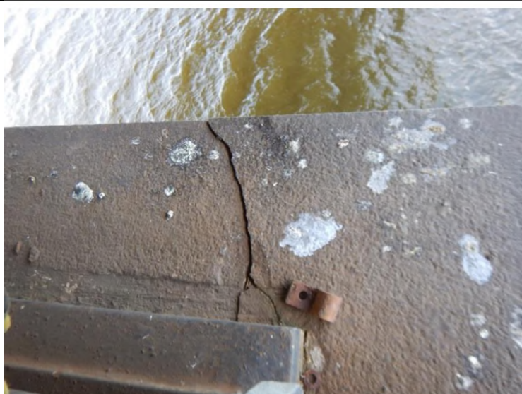
Pilíř P 01 úložný práh:
