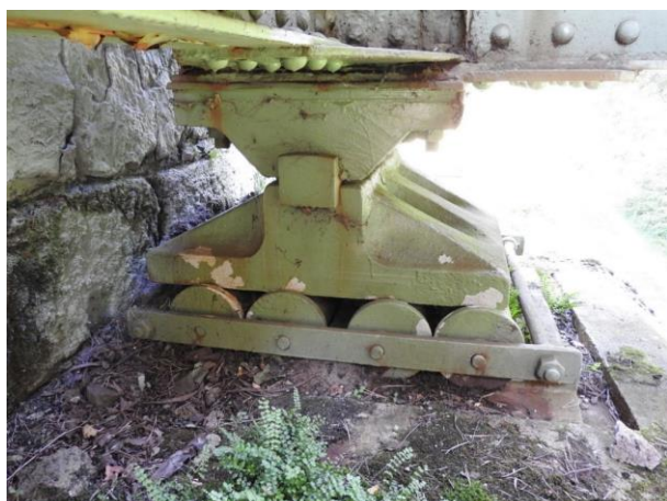
Obr. 13: Zkřížené osy válců pohyblivého ložiska Most v km 34,718 trati Plzeň – Mladotice (č. 13)
