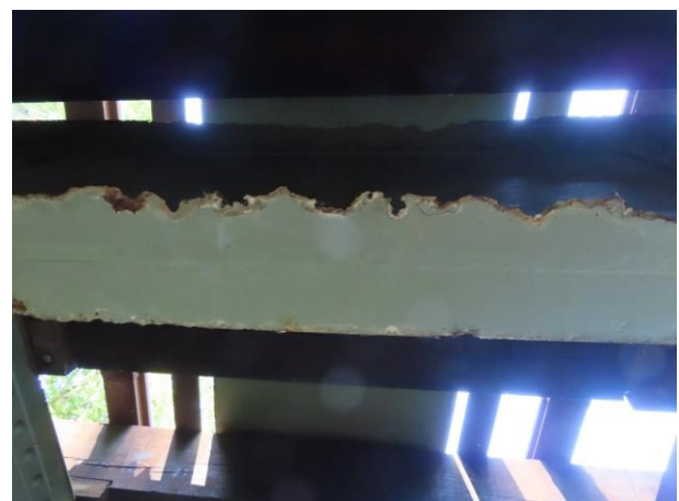
Obr. 2: Oslabení pásnice příčnicku do ostra
