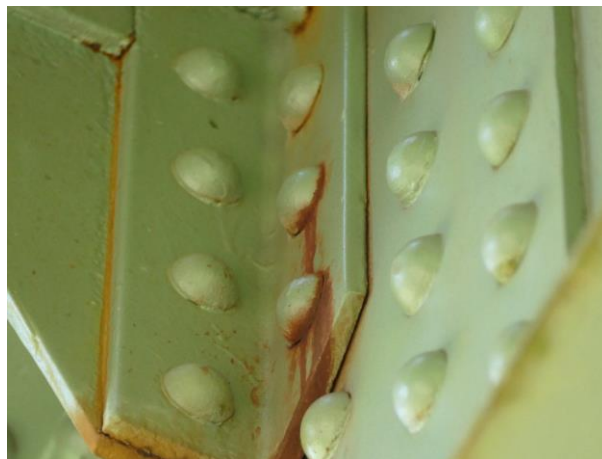
Obr. 4: Uvolněné nýtové spoje
