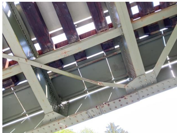
Obr. 2: Deformované prvky a vrypy (K01)
