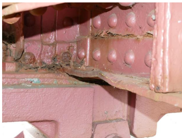
Obr. 2: Deformace úhelníku příčnicku
