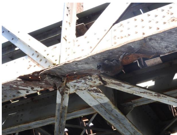
Obr. 18: Rýhy a vrypy Most v km 29,319 trati Dobříš – Vrané n.V.(č. 19)
