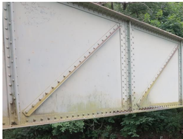
Obr. 2: Znečištění konstrukce v dolních částech
