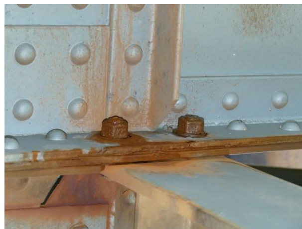
Obr. 2: Povolené šrouby v napojení podélníku
