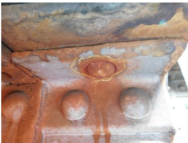
Obr. 3: Uvolněný nýt
