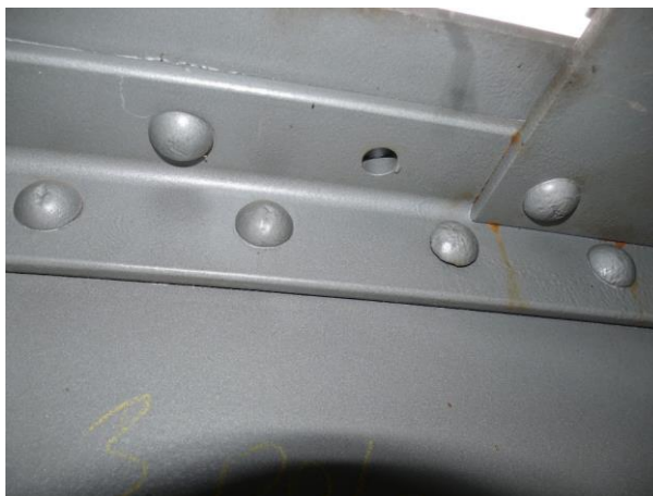
Obr. 2: Chybějící nýt
