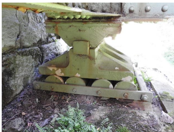
Obr. 4: Zkřížené válce, utržené čepy, zanesení
