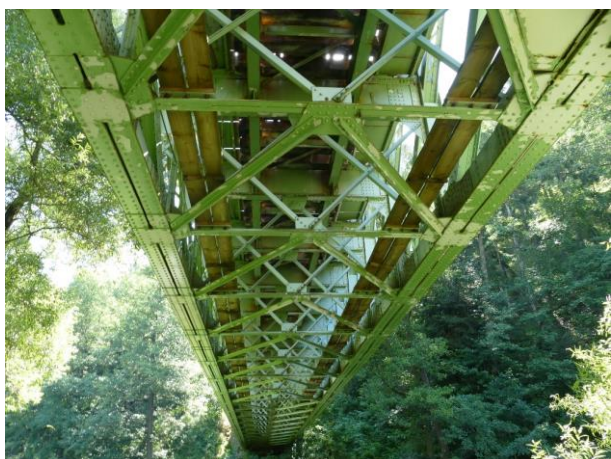
Obr. 3: Ztráta přilnavosti vrchního nátěru
