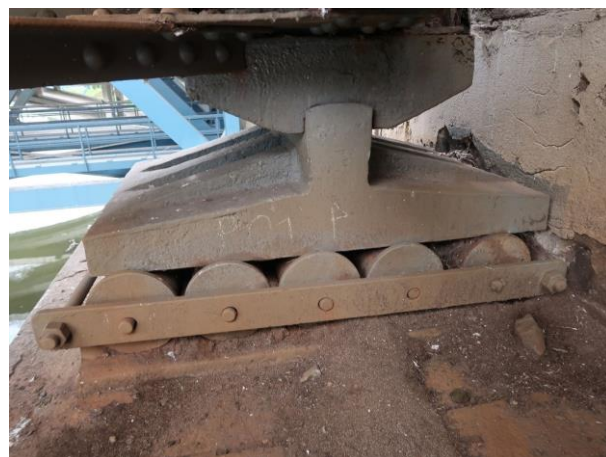
Obr. 4: Deformace čepů válců, vpravo utržený
