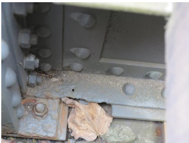
Obr. 1: Podélník nad podružným ložiskem
