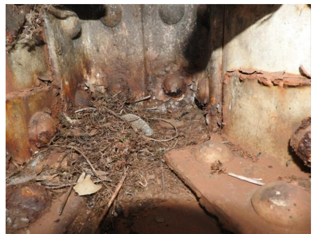
Obr. 4: Nečistoty v zákoutích
