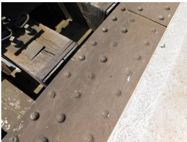
Obr. 1: Důlkovité oslabení pásnice a hlav nýtů
