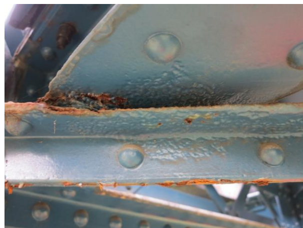
Obr. 2: Štěrbinová koroze
