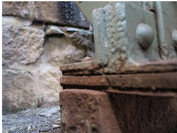
Obr. 2: Podélník nad podružným ložiskem
