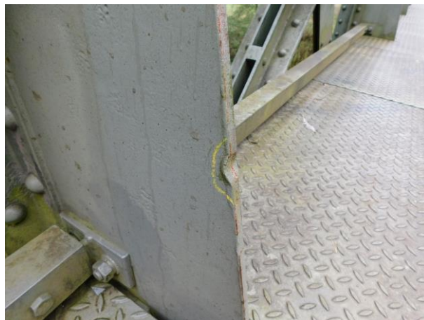
Obr. 2: Vrub v koutové výztuze
