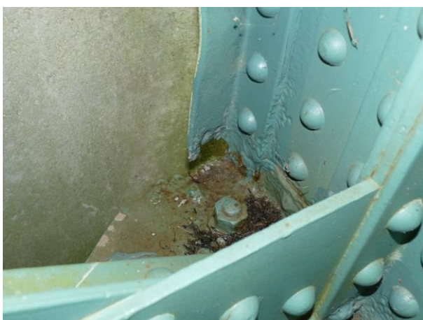
Obr. 3: Deformovaný a oslabený úhelník svislice
