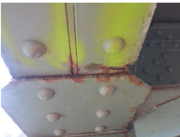
Obr. 4: Štěrbinová koroze
