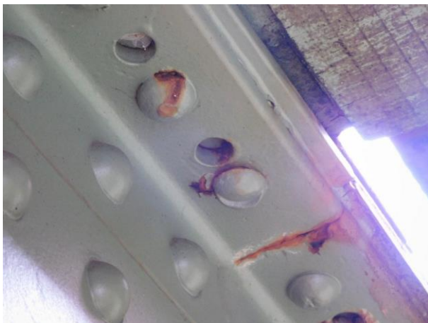
Obr. 1: Volné nýty, ponechané otvory (K03)
