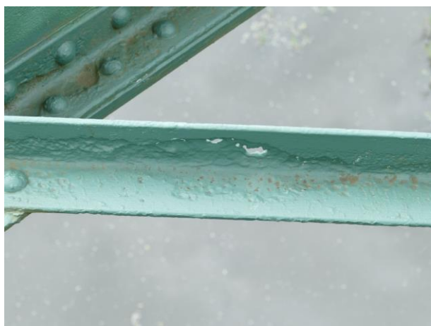
Obr. 3: Prokorodovaný prvek Most v km 20,862 trati Rakona – Mladotice (č. 16)
