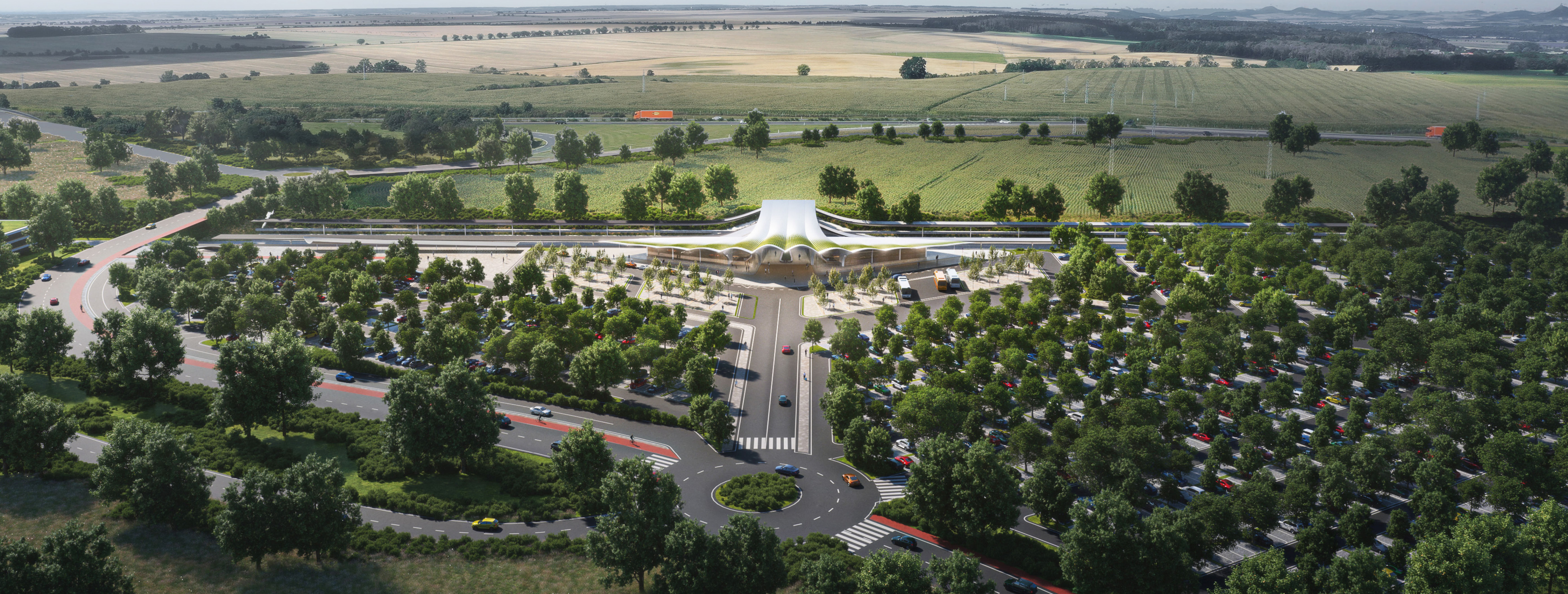
Pohled z páteří komunikace na budovu terminálu
