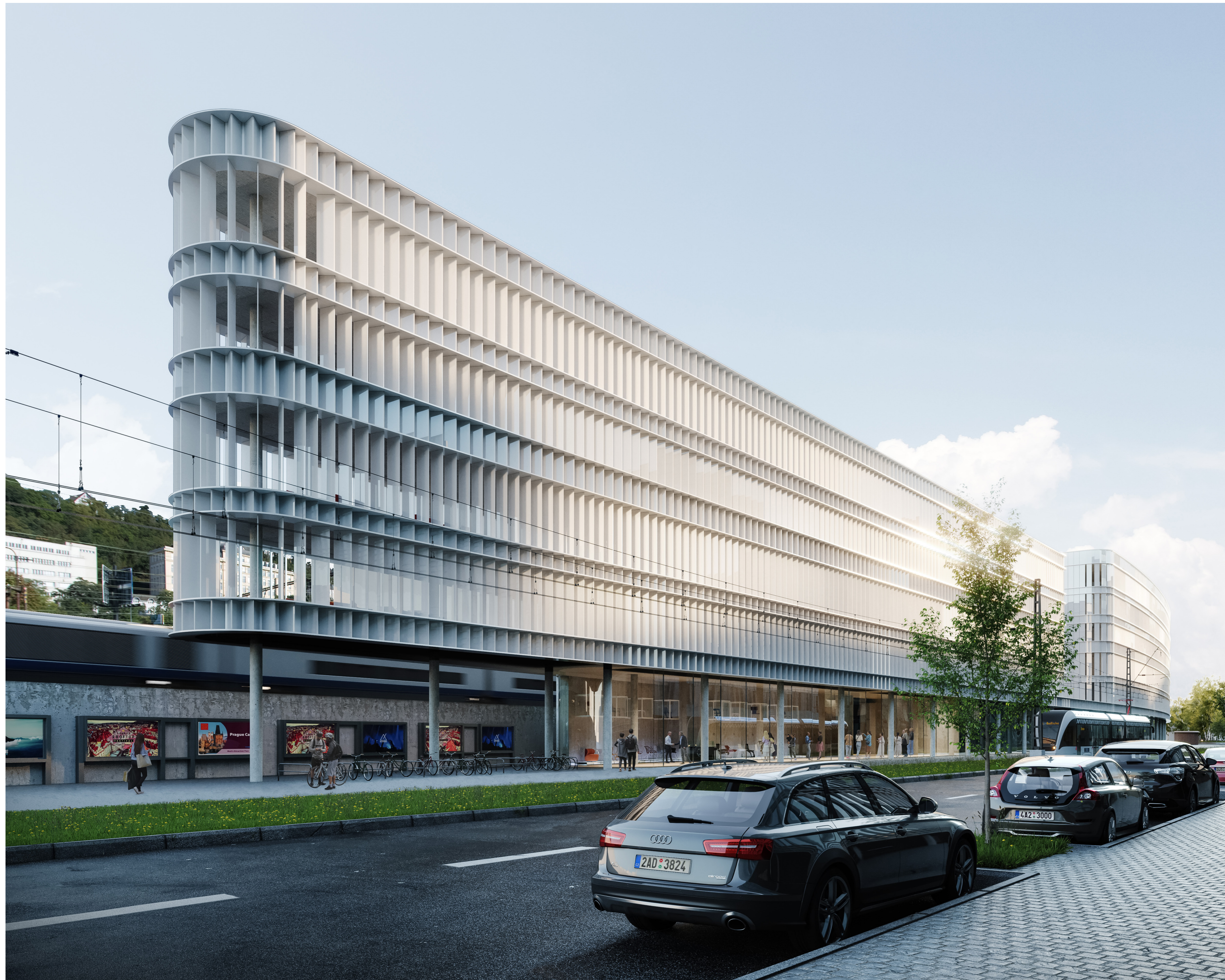
pohled z Nádražní ulice od jihovýchodu
