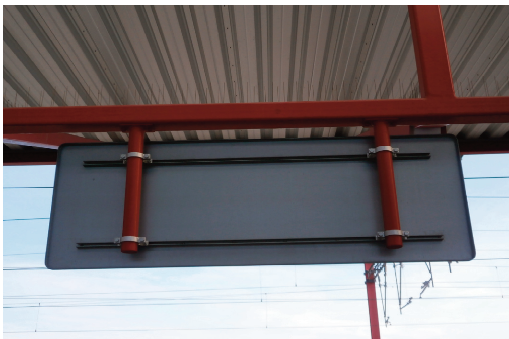
Příklad uchycení tabule ke konstrukci zastřešení (konzoly jsou připravené od výrobce zastřešení, tabule je na ně uchycena na objímky)
