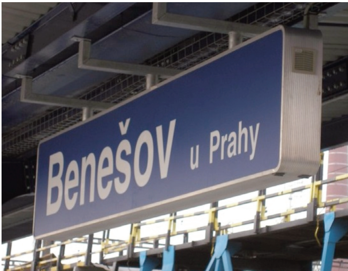
Příklad prosvětleného butonu s větrací mřížkou
