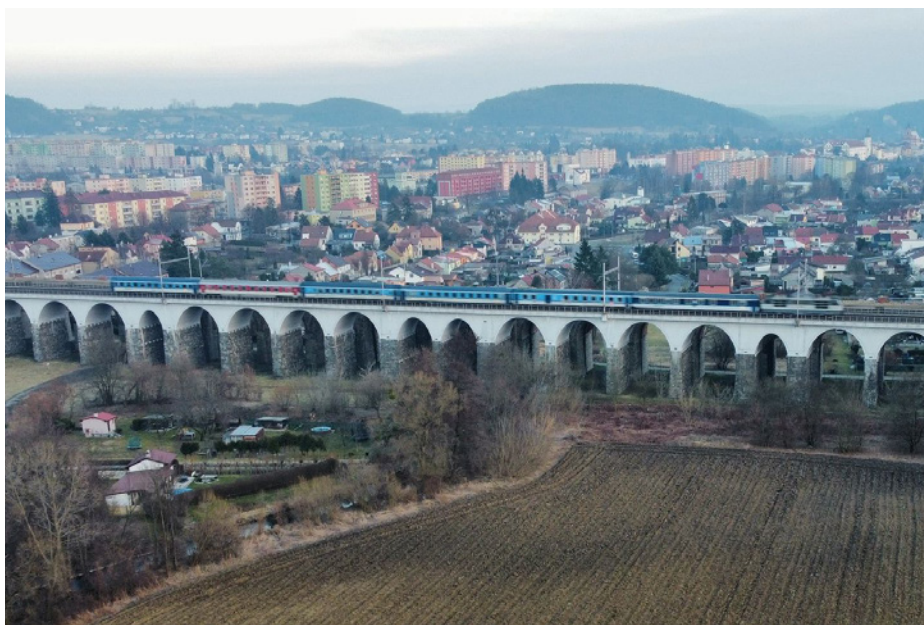
Viadukt v Hranicích (kulturní památka)
