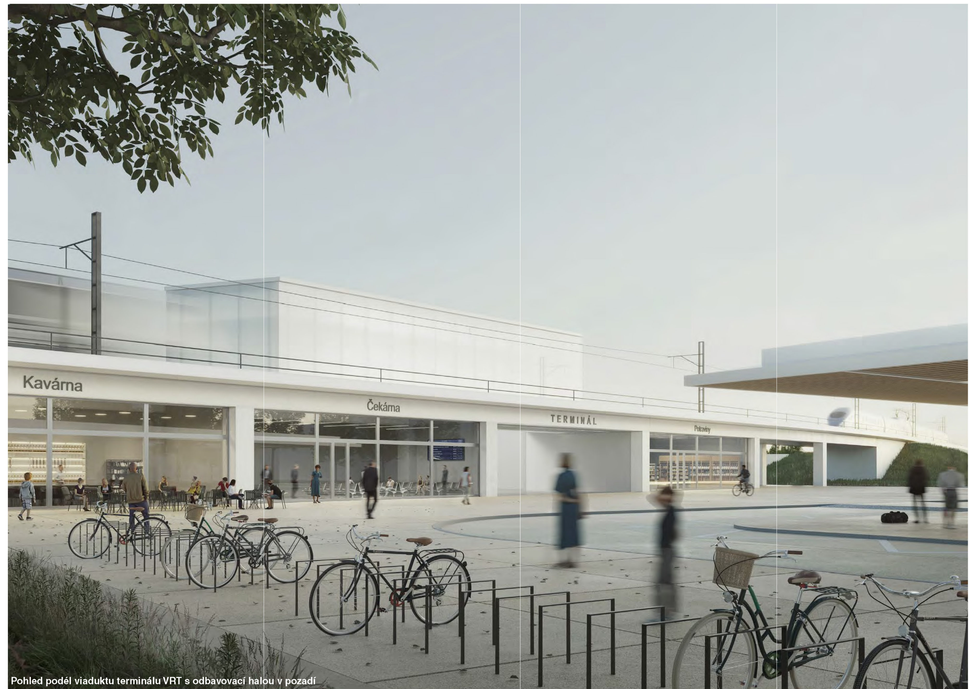
Pohled podél viaduktu terminálu VRT s odbavovací halou v pozadí
