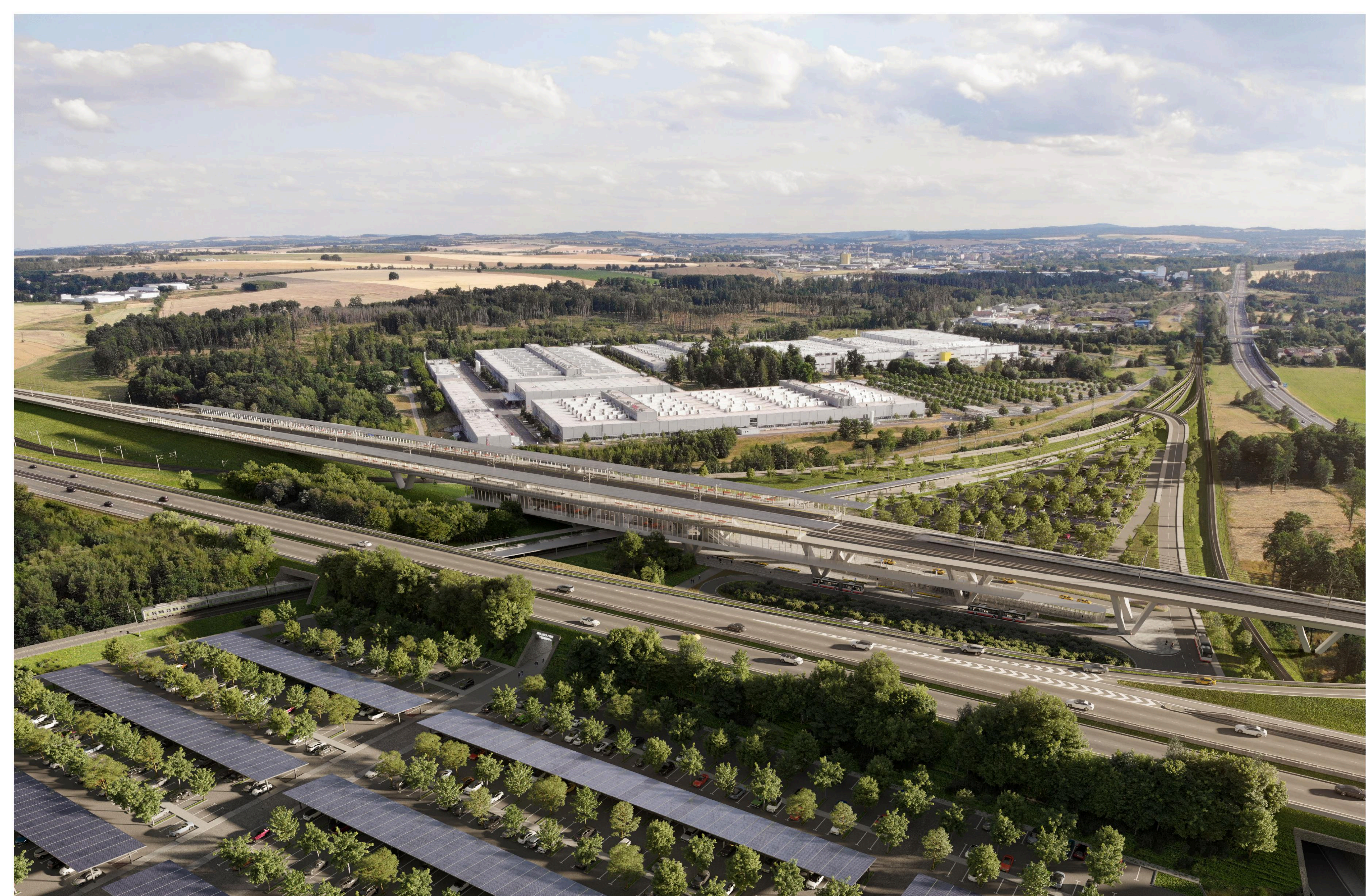
LETECKÝ POHLED NA TERMINÁL
