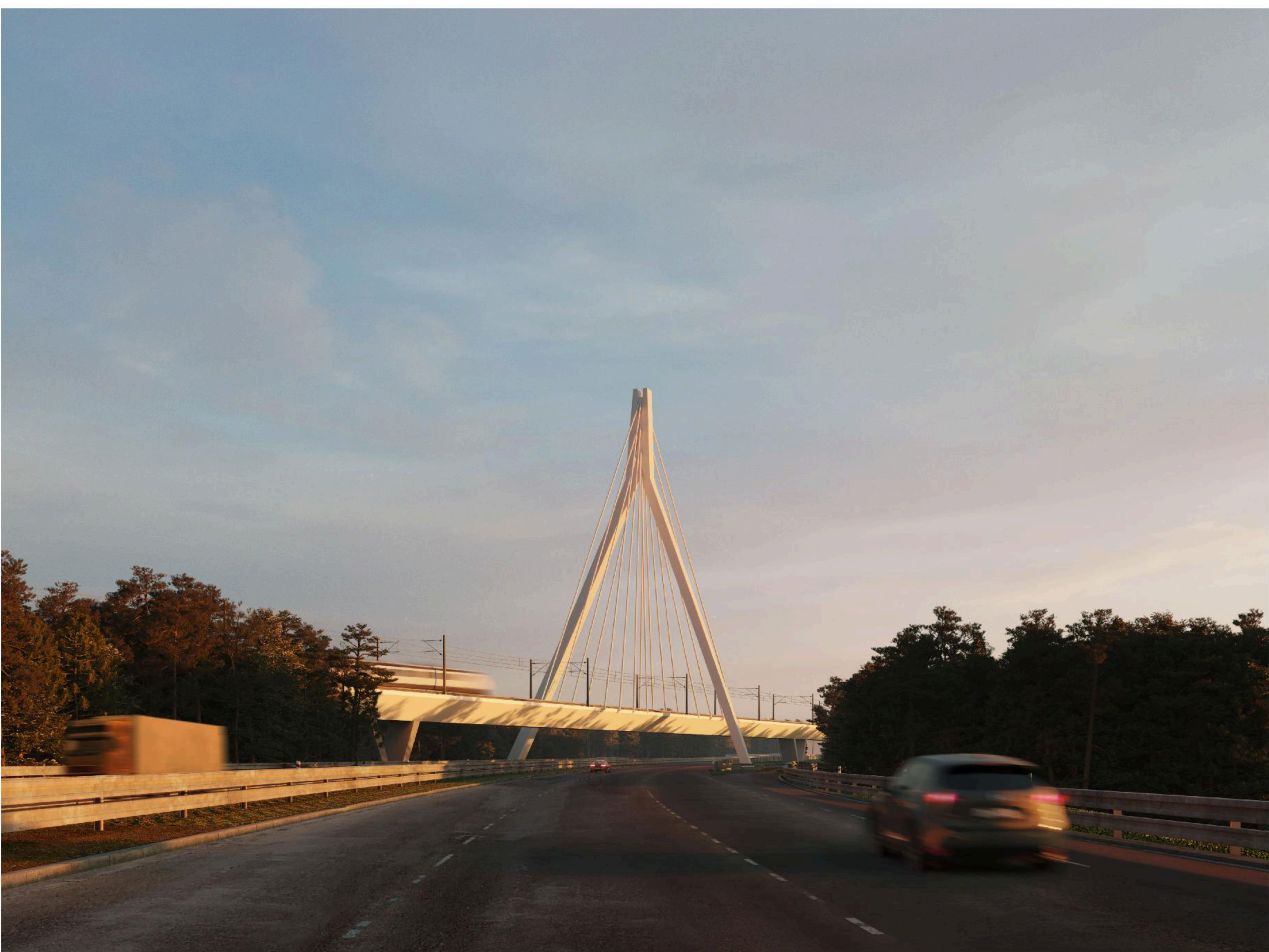
POHLED NA VIADUKT A MOST Z DALNICE D1
