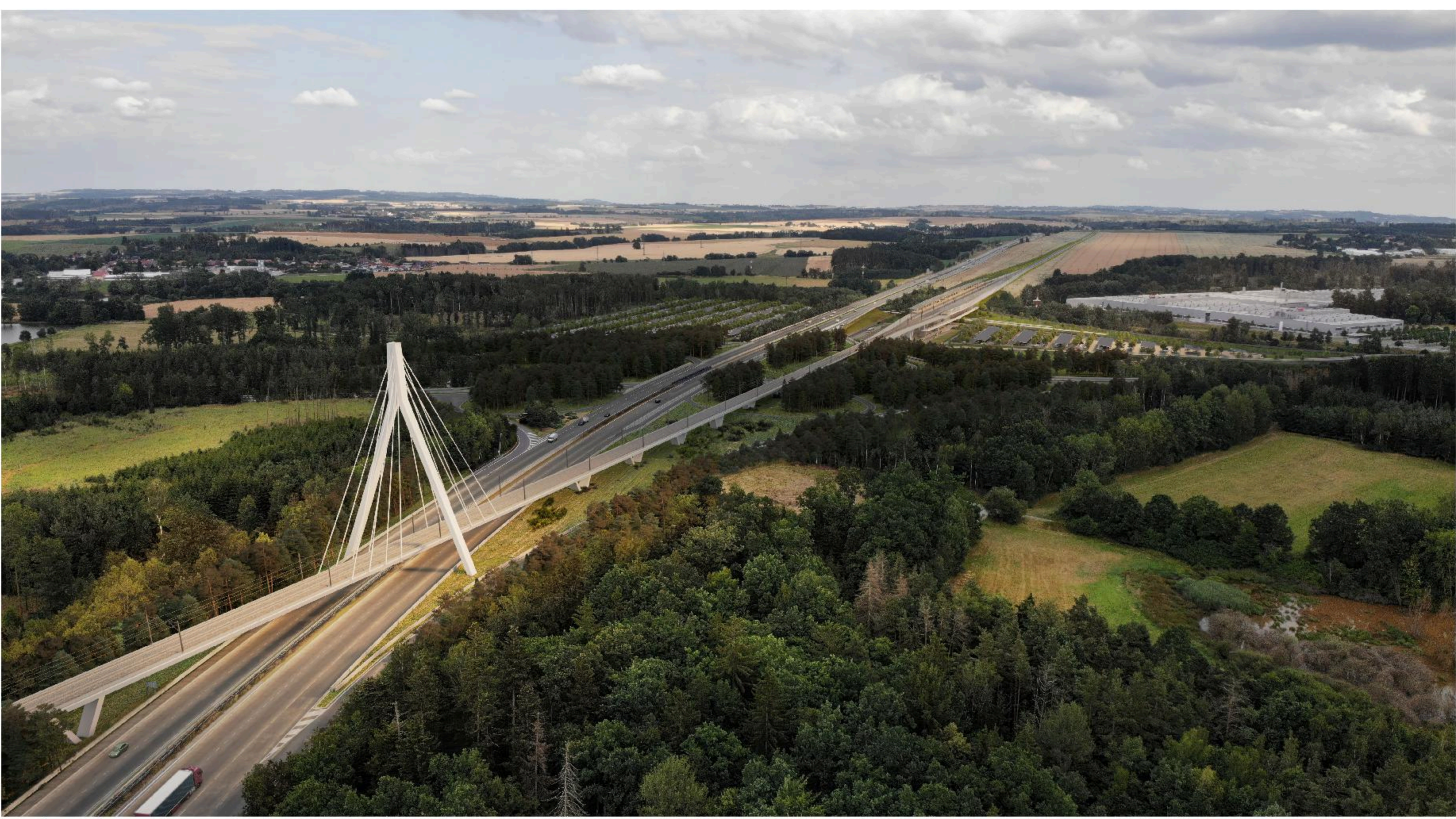
LETECKÝ POHLED NA VIADUKT A MOST
